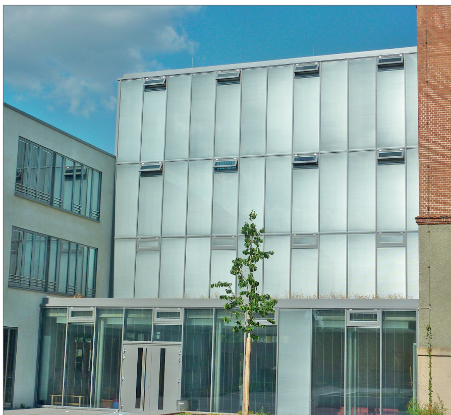
Denkmalschutz und moderner Neubau ergänzen sich an der Schule. Im neu errichteten Abschnitt sorgt ein intelligentes Glasfenstersystem automatisch dafür, dass das Gebäude nicht überhitzt.
