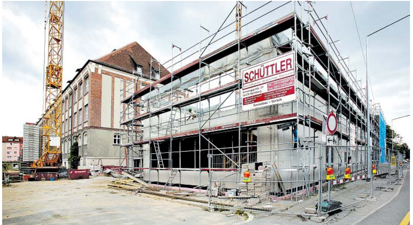
Der Neubau der Adam-Kraft-Realschule wird mit besonderen Fenstern ausgestattet.
